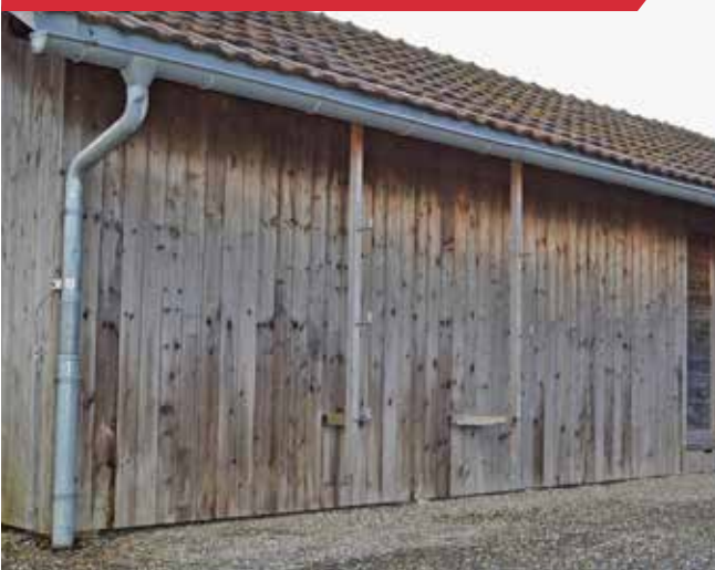
Bois de démolition et démontement (non traité)
